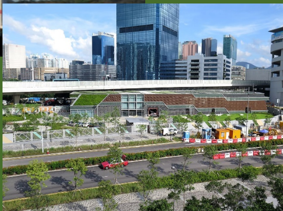
啟德發展區區域供冷系統
